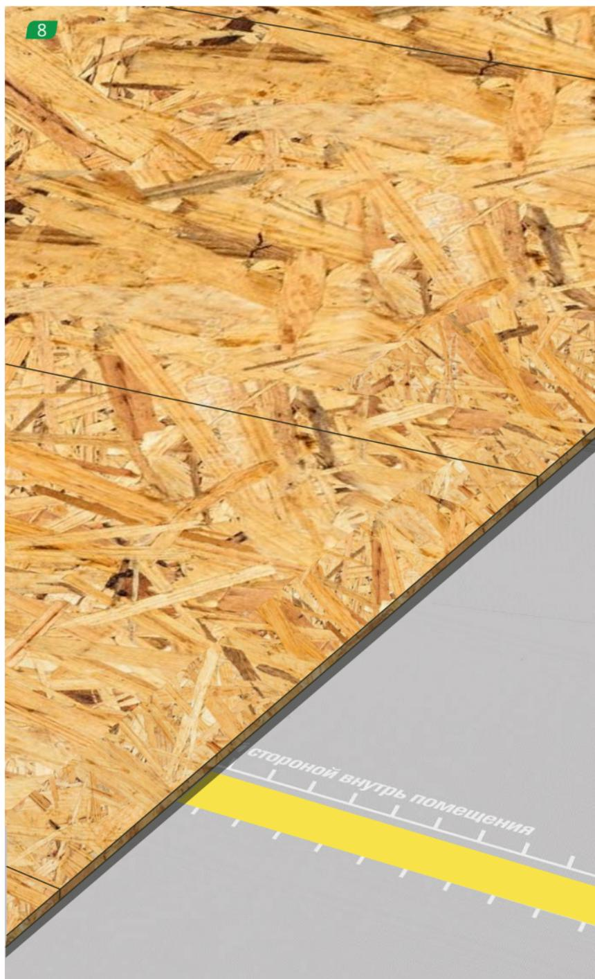
Монтируем основание пола (например, из ОСБ-плит), на которые будет укладываться материал для чистовой отделки (линолеум, ламинат, паркет и т.п.), согласно инструкции его производителя.
