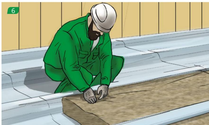
Теплоизоляция должна плотно прилегать к элементам конструкции и фиксироваться враспор. Не должно быть щелей и стыков.
