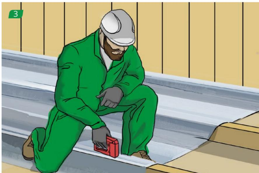
Поверх конструкции чернового пола раскатываем ветрозащитную мембрану - слева направо или справа налево.
