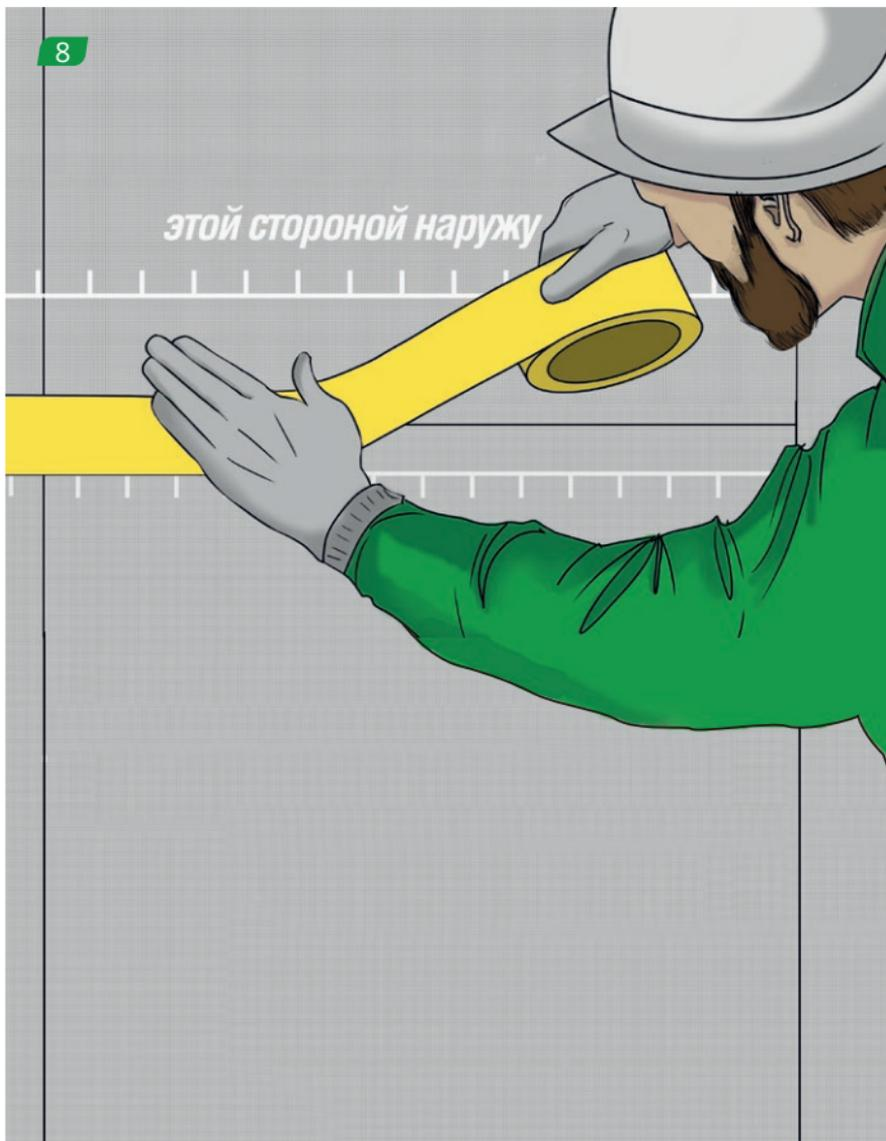
Стыки желательно, а точки повреждения мембраны - обязательно - проклеиваем лентой для проклейки швов.
