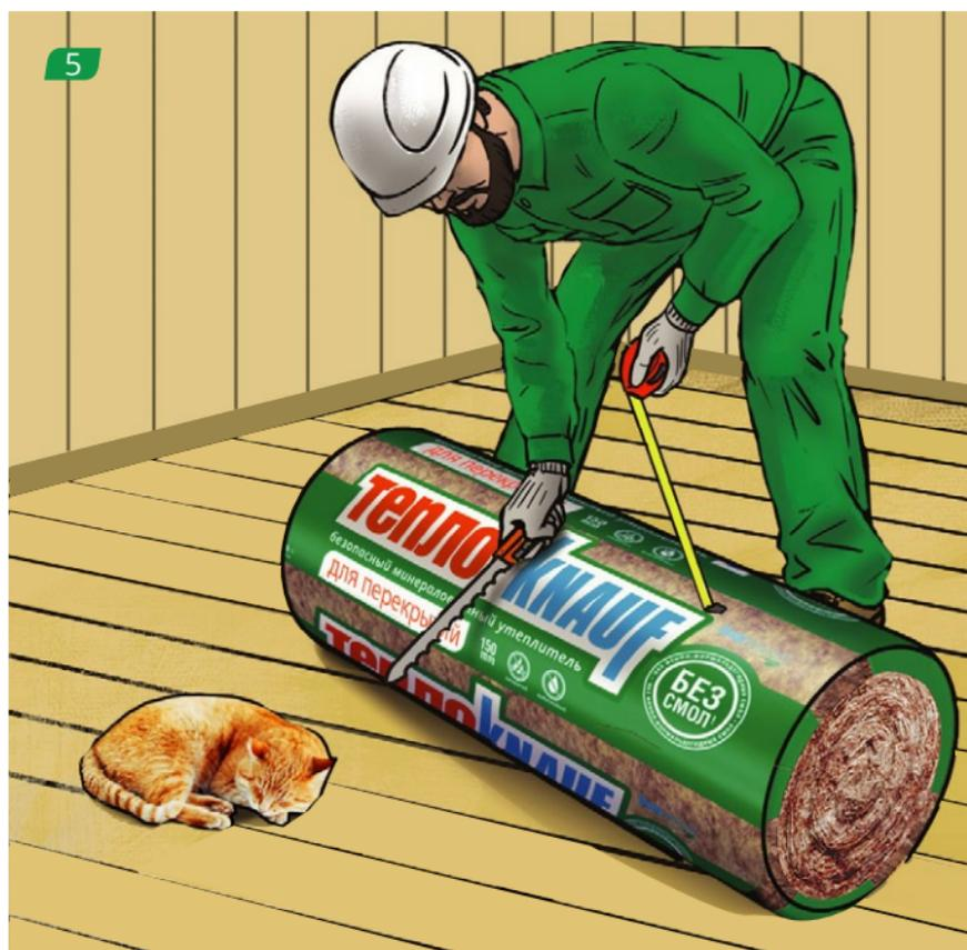
Нарезаем теплоизоляцию по ширине из расчета «шаг стропил («в свету») + 10 мм». В расстояние между лагами укладываем утеплитель. При укладке более одного слоя утеплителя каждый последующий слой укладываем с перекрытием стыков.
