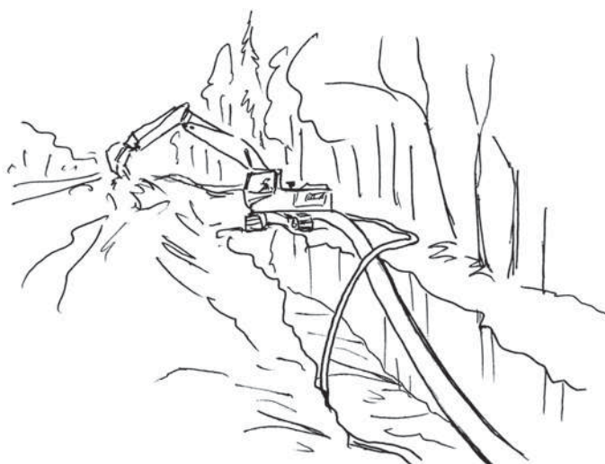
Рис. 4.1.1. Укладка в траншею трубопроводов, смонтированных на поверхности
