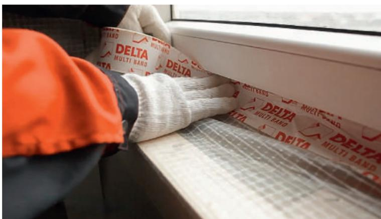
Рис. 3.12. Проклейка примыканий пароизоляции к стенам и окну
