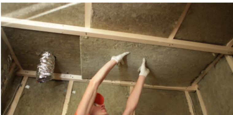
Рис. 4.2. Укладка плит теплоизоляции
