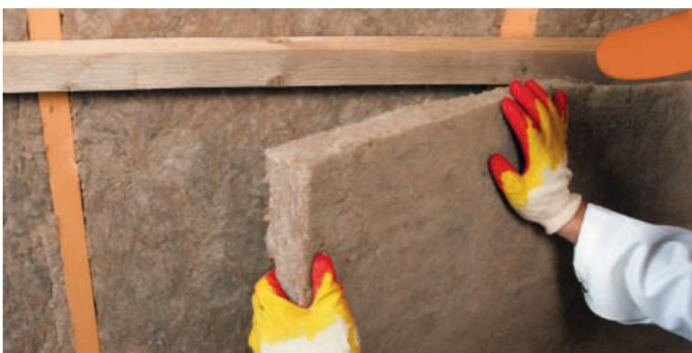
Рис. 3.5. Укладка дополнительного слоя теплоизоляции
