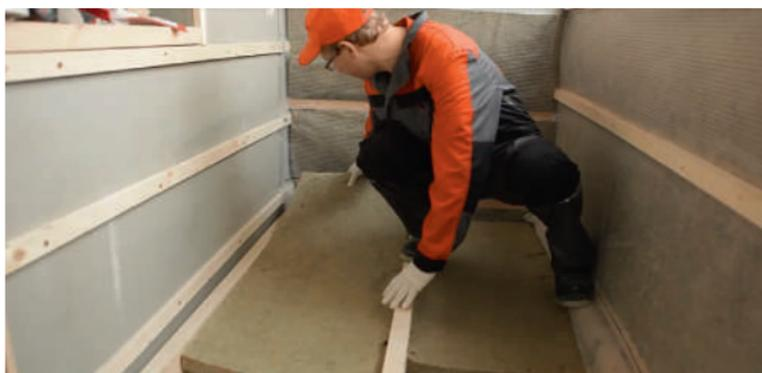
Рис. 5.9. Укладка теплоизоляционных плит
