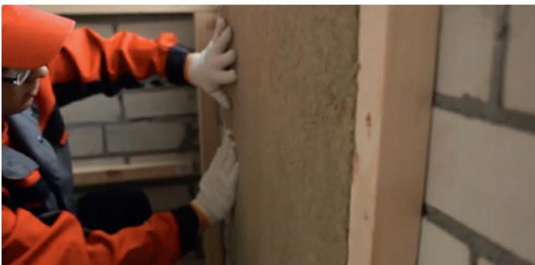
Рис. 5.2. Укладка плит теплоизоляции первого слоя
