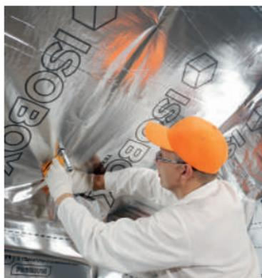
Рис. 3.6. Укладка и фиксация пароизоляционной пленки
