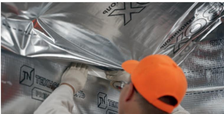
Рис. 3.7. Проклейка стыков пароизоляционной пленки
