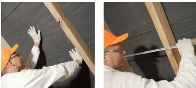
Рис. 3.2. Подготовленная система для дальнейшего монтажа теплоизоляции
