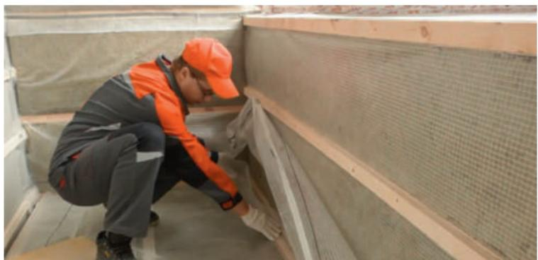
Рис. 5.10. Монтаж пароизоляционной пленки
