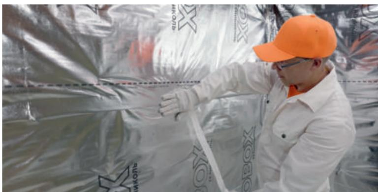
Рис. 2.7. Герметизация стыка двух полотен пленки
