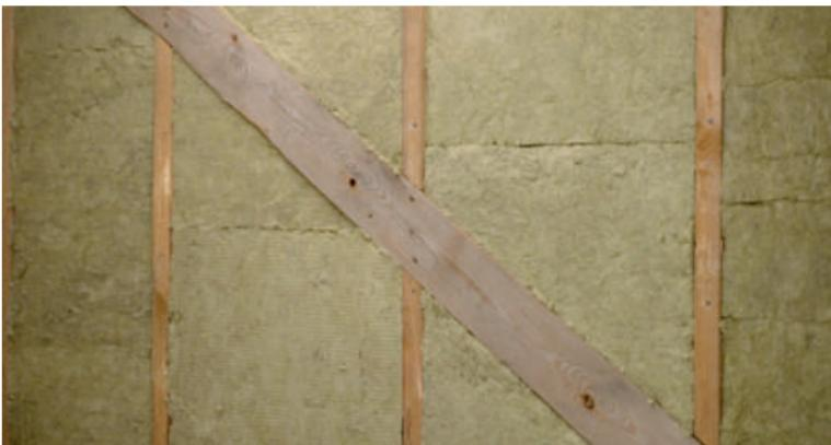
Рис. 2.4. Смонтированная теплоизоляция
