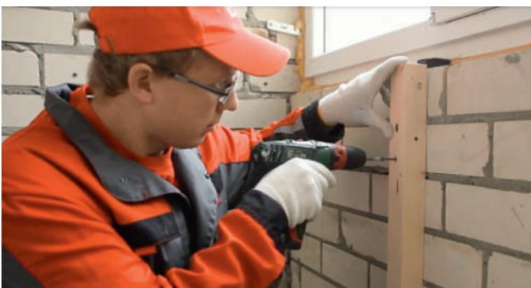
Рис. 5.1. Установка вертикального каркаса под теплоизоляцию
