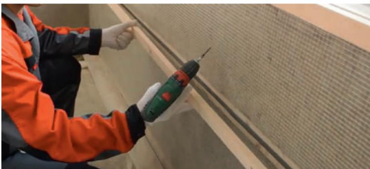
Рис. 5.6. Монтаж контррейки
