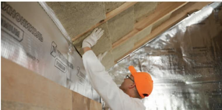
Рис. 3.3. Монтаж теплоизоляции враспор между стропилами
