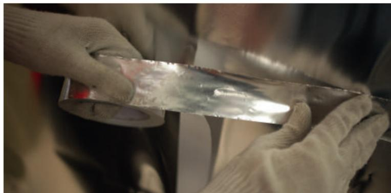
Рис. 4.4. Проклейка стыков пароизоляции
