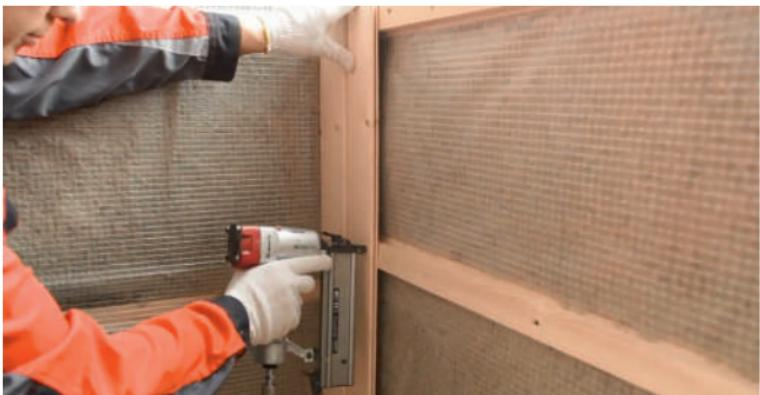
Рис. 5.7. Устройство внутренней обшивки
