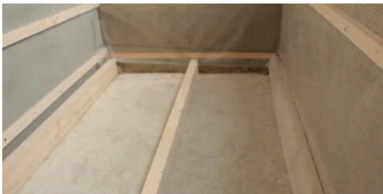
Рис. 5.8. Монтаж деревянных лаг на пол
