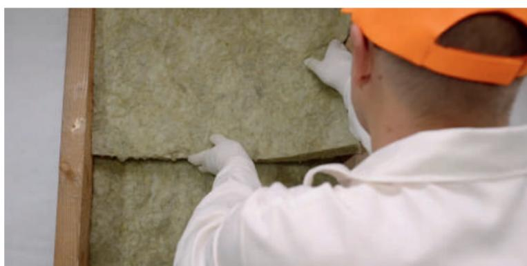
Рис. 2.3. Установка второго слоя теплоизоляции с разбежкой швов
