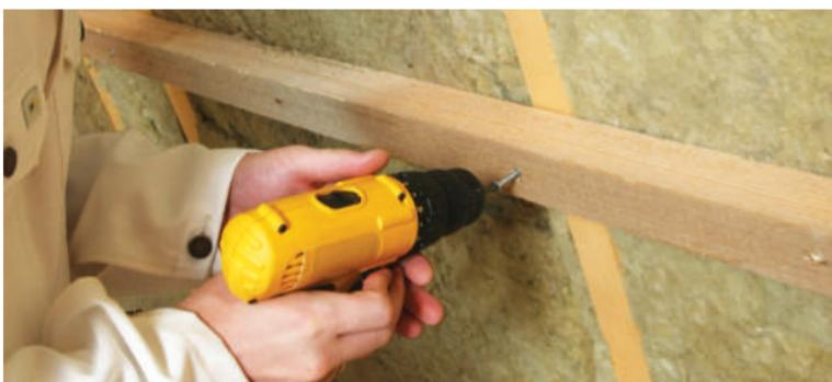
Рис. 3.4. Установка дополнительной деревянной обрешетки
