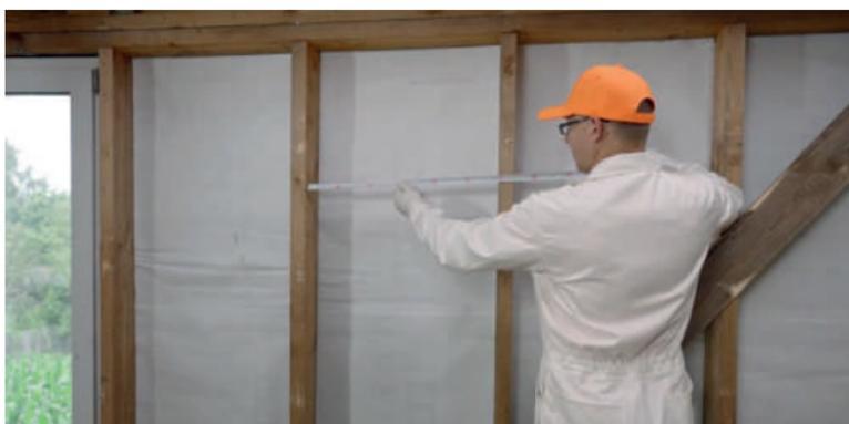
Рис. 2.1. Контрольный замер шага стоек каркаса
