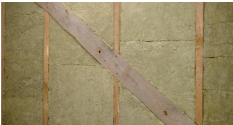
Рис. 2.4. Смонтированная теплоизоляция
