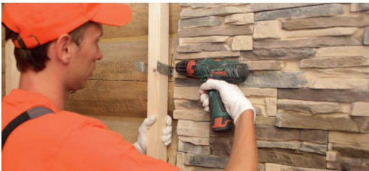
Рис. 4.1.б. Установка каркаса под теплоизоляцию
