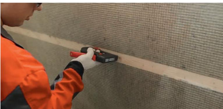
Рис.5.5. Монтаж пароизоляции
