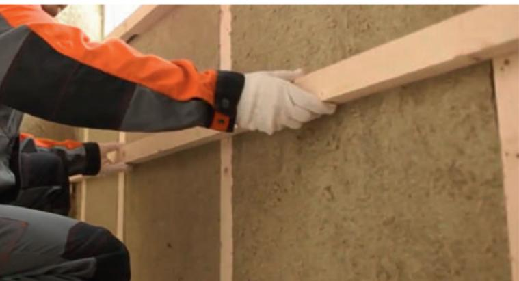
Рис. 5.3. Установка горизонтального каркаса под теплоизоляцию
