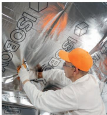
Рис. 3.6. Укладка и фиксация пароизоляционной пленки
