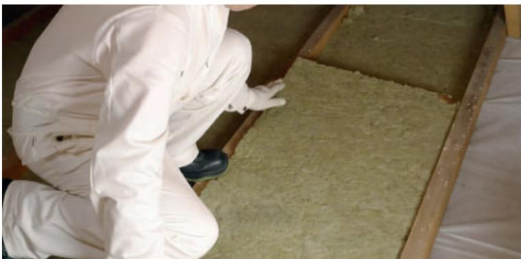
Рис.3.12. Монтаж теплоизоляции между балками
