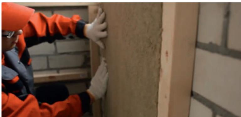
Рис. 5.2. Укладка плит теплоизоляции первого слоя
