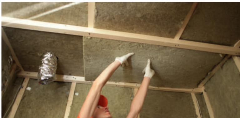
Рис. 4.2. Укладка плит теплоизоляции
