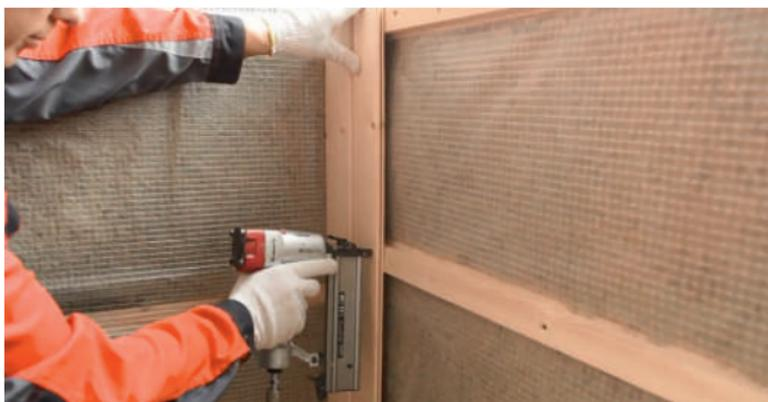
Рис. 5.7. Устройство внутренней обшивки
