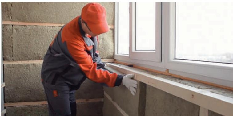
Рис. 5.4. Укладка плит теплоизоляции второго слоя
