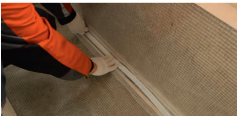
Рис. 3.11. Проклейка нахлестов пароизоляции
