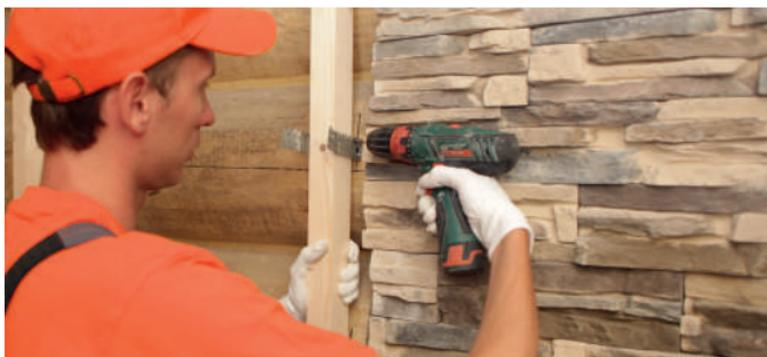
Рис. 4.1.б. Установка каркаса под теплоизоляцию
