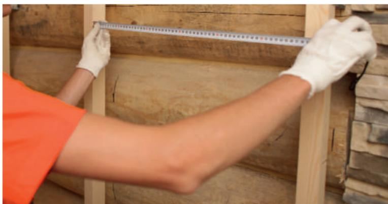
Рис. 4.1.а. Установка каркаса под теплоизоляцию
