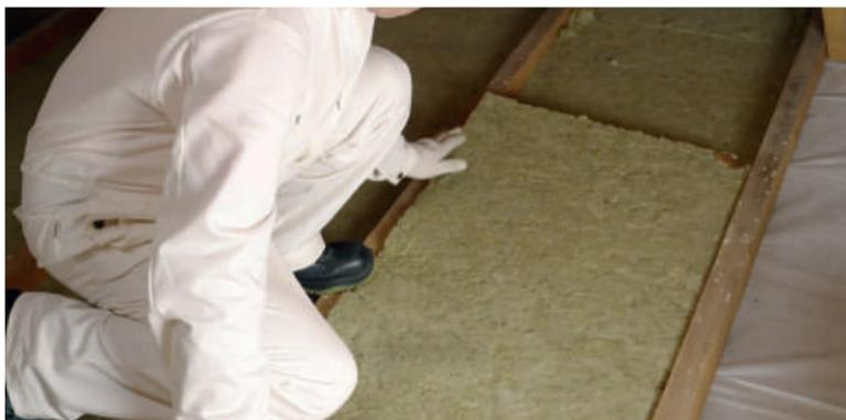
Рис.3.12. Монтаж теплоизоляции между балками
