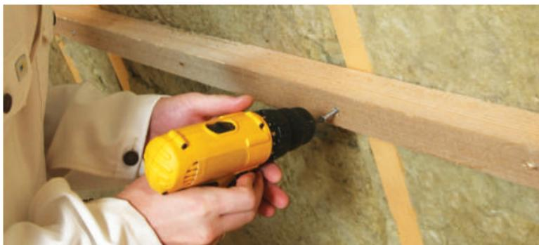
Рис. 3.4. Установка дополнительной деревянной обрешетки
