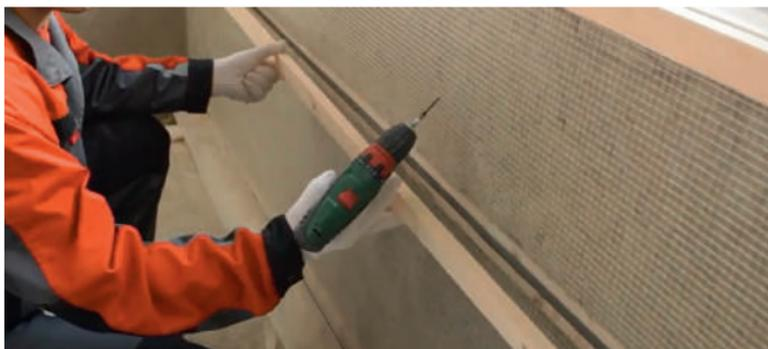
Рис. 5.6. Монтаж контррейки
