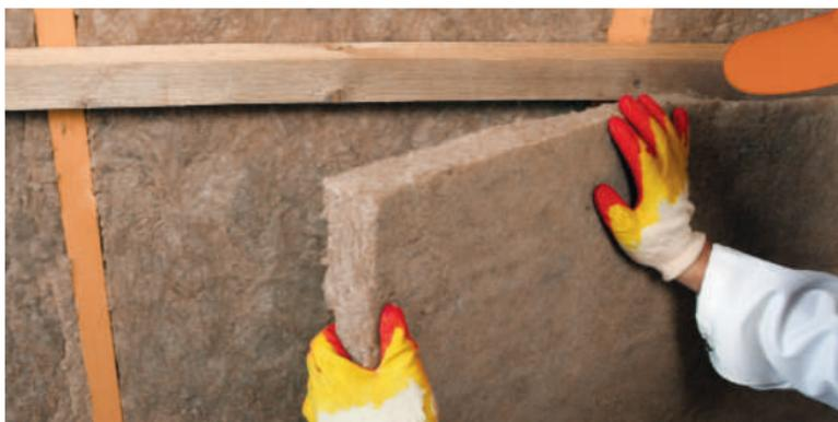
Рис. 3.5. Укладка дополнительного слоя теплоизоляции
