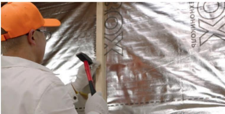
Рис. 2.8. Монтаж контрреек для устройства внутренней облицовки
