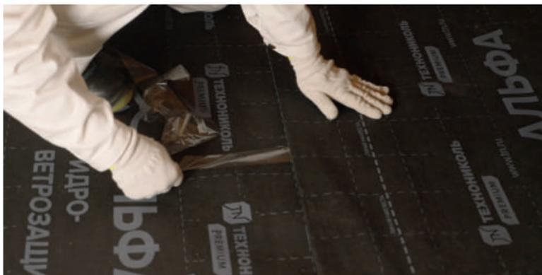
Рис. 3.13. Монтаж гидро-ветрозащитной мембраны
