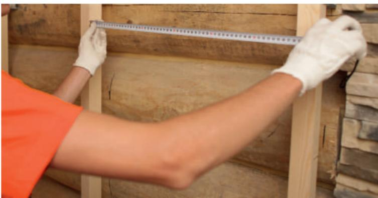
Рис. 4.1.а. Установка каркаса под теплоизоляцию
