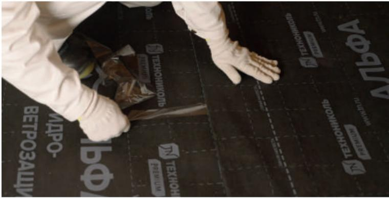
Рис. 3.13. Монтаж гидро-ветрозащитной мембраны
