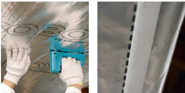
Рис. 3.10. Монтаж пароизоляционной пленки
