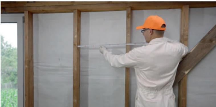
Рис. 2.1. Контрольный замер шага стоек каркаса
