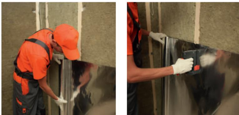
Рис. 4.3. Монтаж пароизоляции
