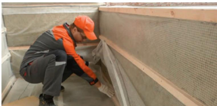
Рис. 5.10. Монтаж пароизоляционной пленки
