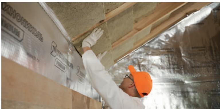
Рис. 3.3. Монтаж теплоизоляции враспор между стропилами
