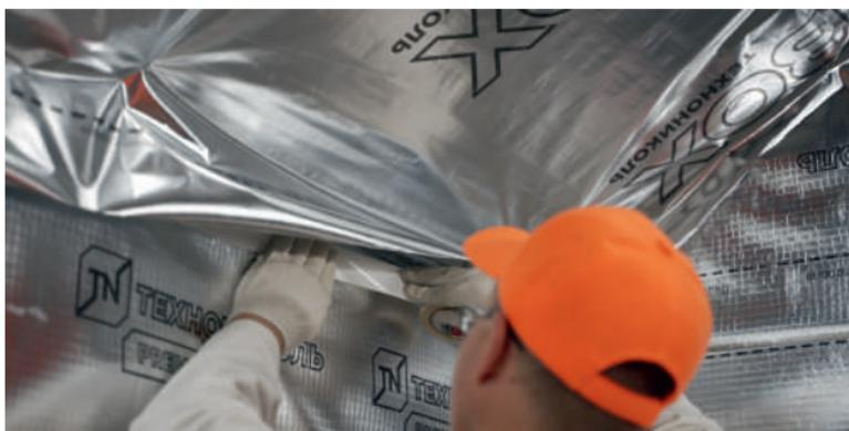
Рис. 3.7. Проклейка стыков пароизоляционной пленки
