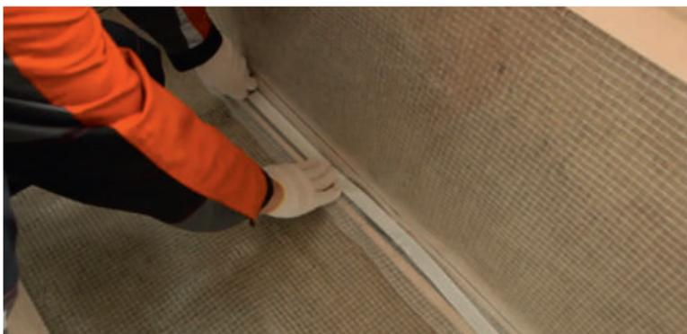
Рис. 3.11. Проклейка нахлестов пароизоляции
