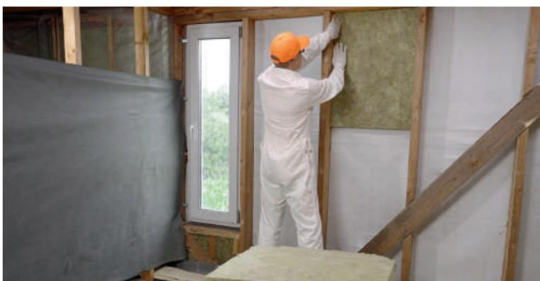
Рис. 2.2. Установка теплоизоляции враспор между стойками каркаса
