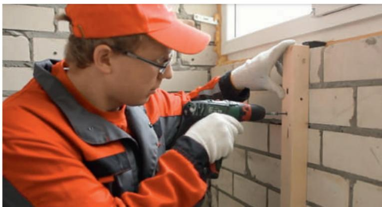
Рис. 5.1. Установка вертикального каркаса под теплоизоляцию
