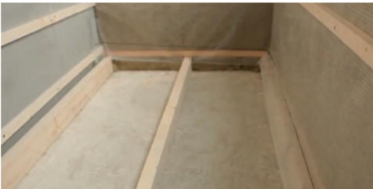
Рис. 5.8. Монтаж деревянных лаг на пол
