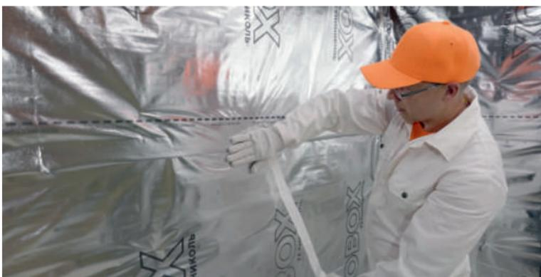
Рис. 2.7. Герметизация стыка двух полотен пленки
