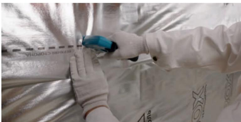
Рис. 2.5. Укладка и фиксация пароизоляционной пленки
