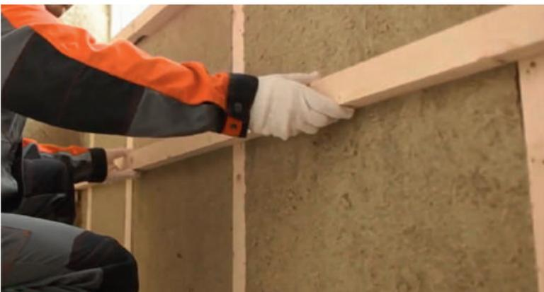
Рис. 5.3. Установка горизонтального каркаса под теплоизоляцию
