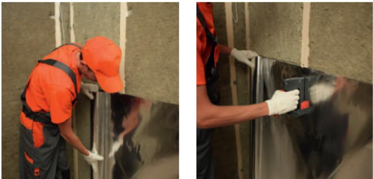
Рис. 4.3. Монтаж пароизоляции
