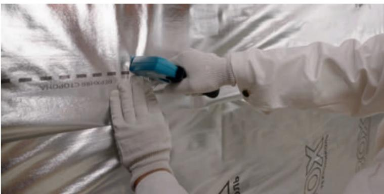
Рис. 2.5. Укладка и фиксация пароизоляционной пленки
