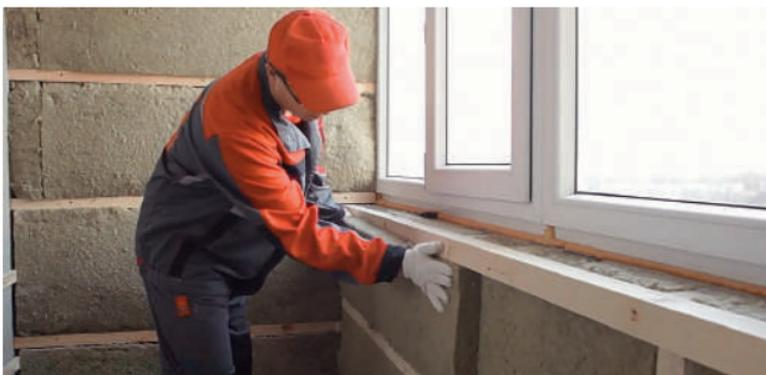
Рис. 5.4. Укладка плит теплоизоляции второго слоя
