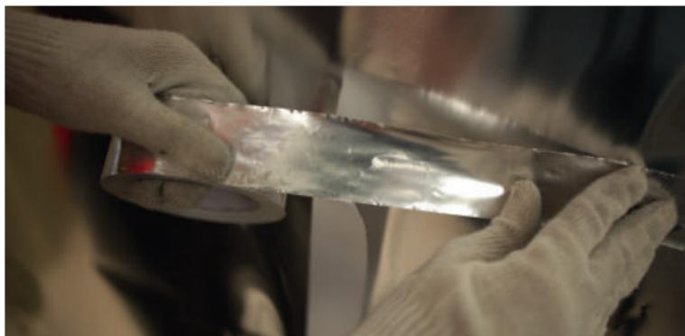
Рис. 4.4. Проклейка стыков пароизоляции
