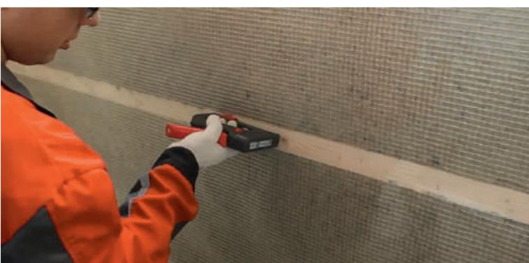
Рис.5.5. Монтаж пароизоляции
