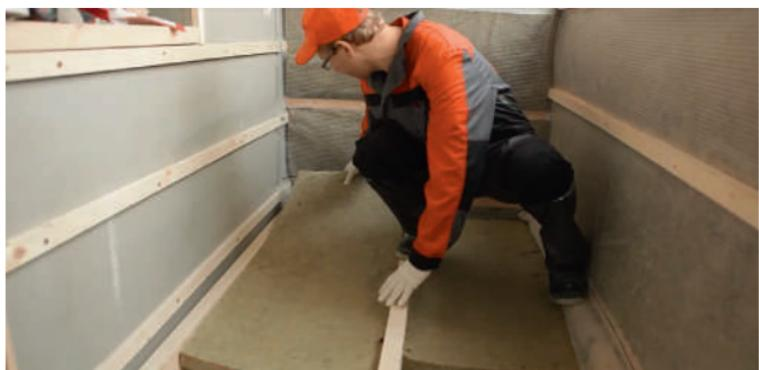
Рис. 5.9. Укладка теплоизоляционных плит
