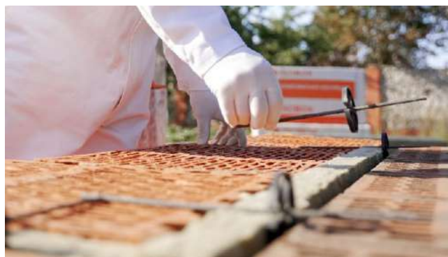
Рис. 2.9. Установка гибких связей
