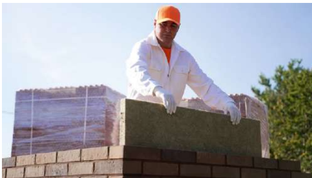
Рис. 2.8. Монтаж плит ИЗОБОКС ИНСАЙД
