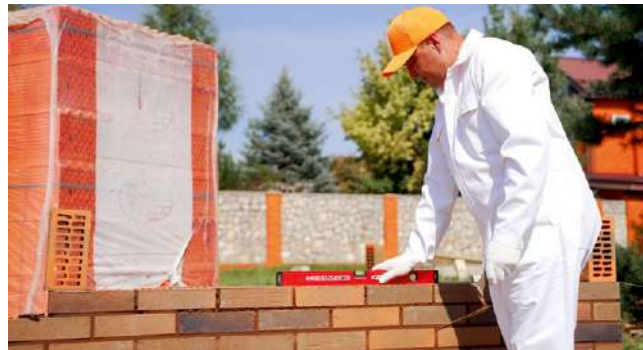
Рис. 2.2. Возведение кирпичной кладки
