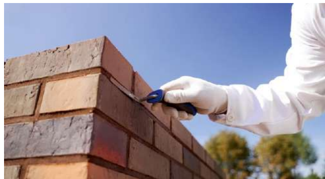
Рис. 2.3. Расшивка швов кельмой
