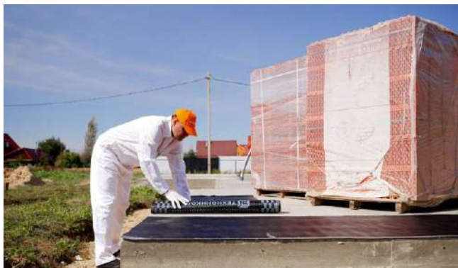
Рис. 2.1. Подготовка основания фундамента
