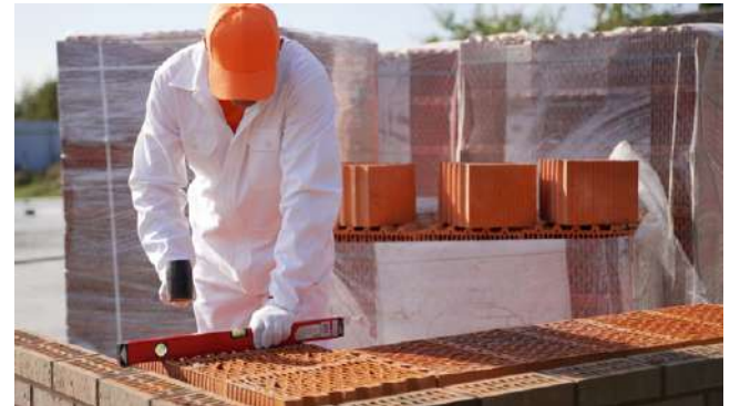
Рис. 2.6. Возведение внутренней несущей стены
