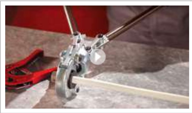
Монтаж металлопластиковых труб.
