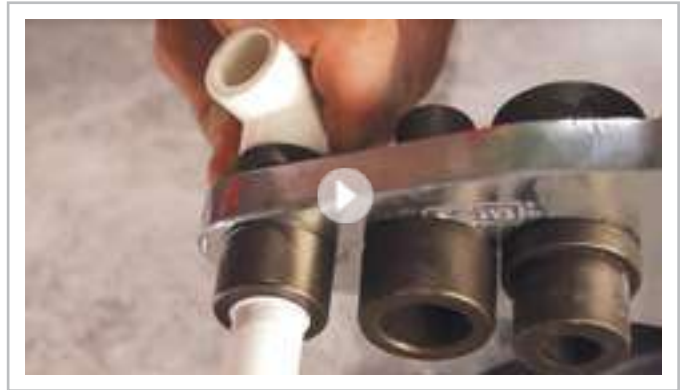
Монтаж полипропиленовых труб.
