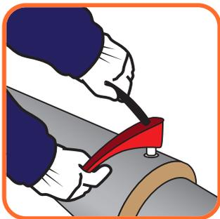
Зафиксируйте заклепку с помощью ручного заклепочника.
