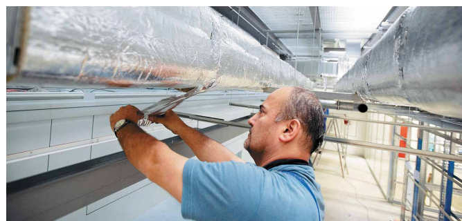
Использование LAMELLA MAT для теплоизоляции системы кондиционирования воздуха
