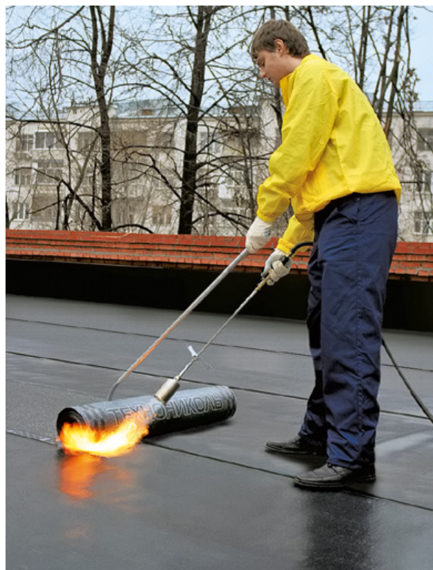
Рис. 4.13. Положение рабочего при укладке.
