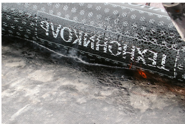
Рис. 4.15. Валик расплавленного битумно-полимерного вяжущего
