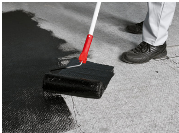
Рис. 4.7. Нанесение грунтовки.
