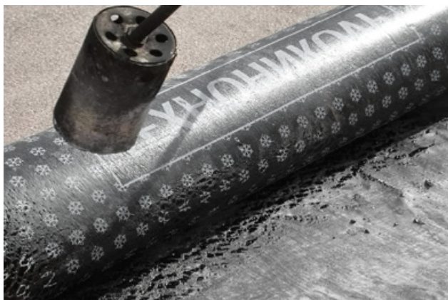
Рис. 4.14. Деформация рисунка на нижней стороне материала при правильном разогреве
